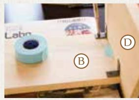
⑤側面に固定したL型金物を④中段に固定。先にマスキングテープで仮固定しておくと作業しやすいです。
